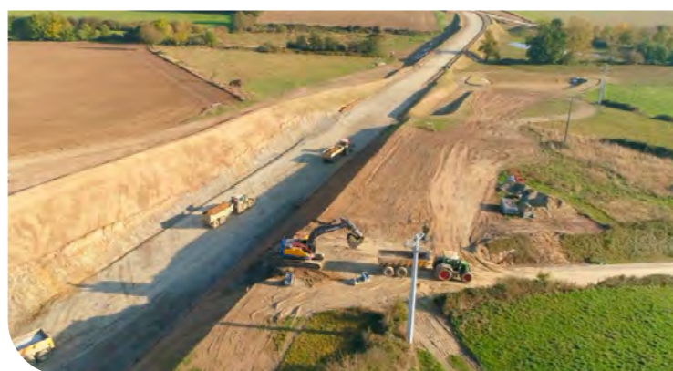
■ Contournement Phase terrassements
