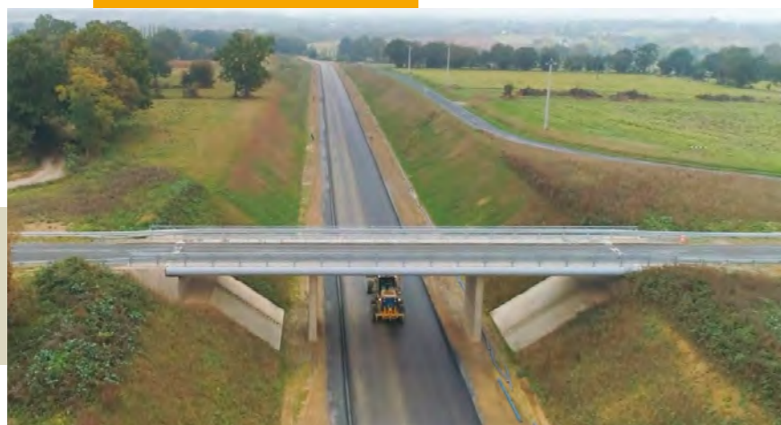
Rétablissement CR 23 passage supérieur
