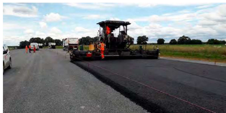
Section à 2 x 2 voies – Réalisation de la chaussée
