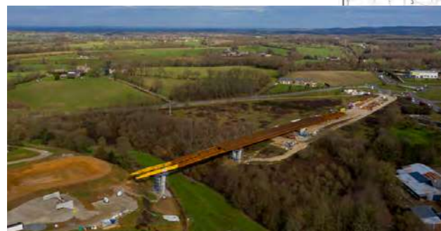
■ Viaduc de La Villette Phase du lancement du tablier
