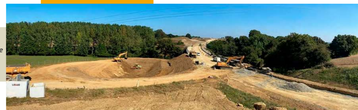
Terrassement section courante Ouest du Bouillon
