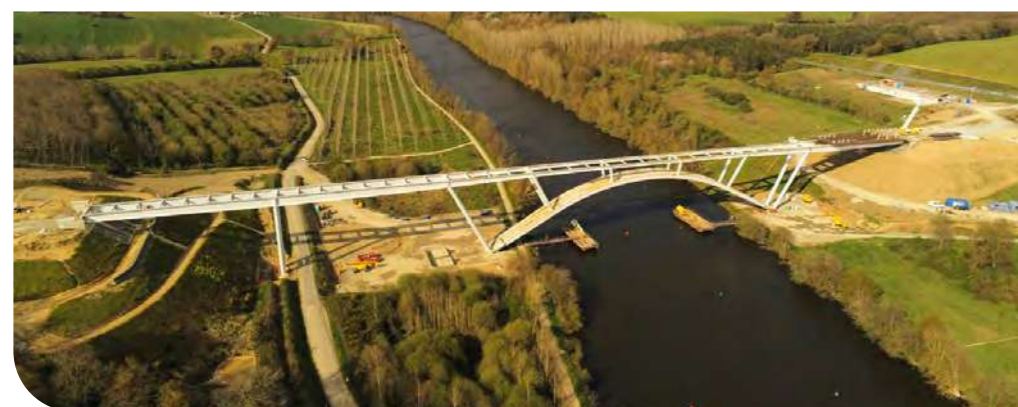
■ Viaduc sur la rivière La Mayenne
