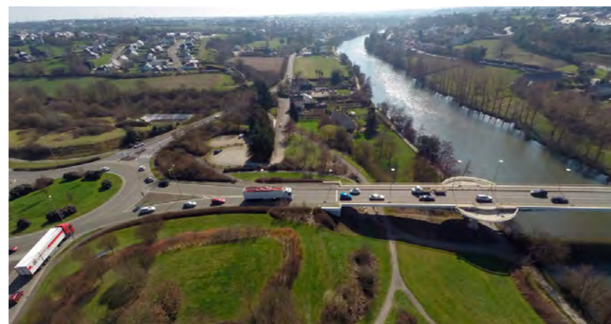
■ Pont de Pritz à Laval
