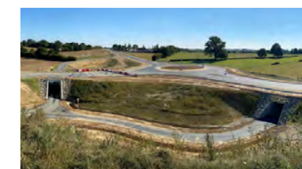
■ RD 1 – Ouverture section sud
